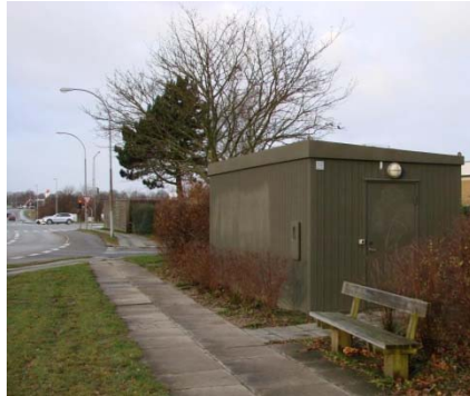
Billede 1 – Eksempel på teknikhus
